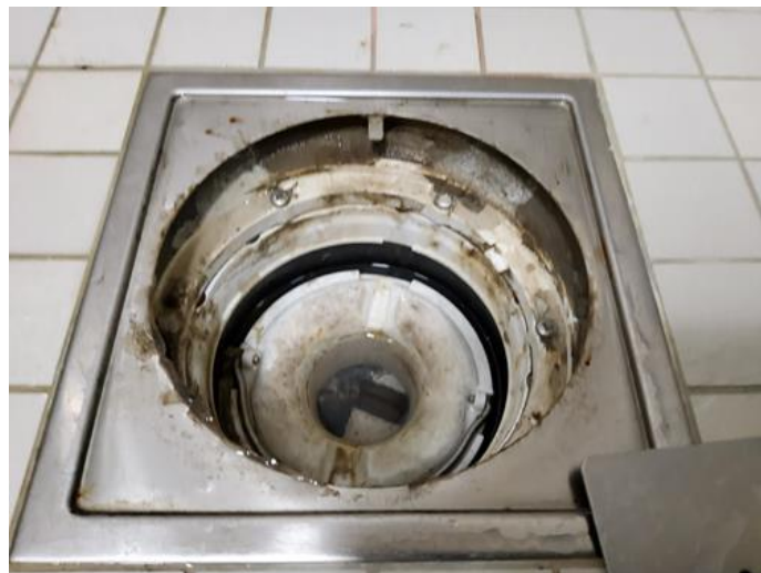
Membran, tettesjikt og overgang til sluk. - [Sluk i bad 1. etg. 4B ]
