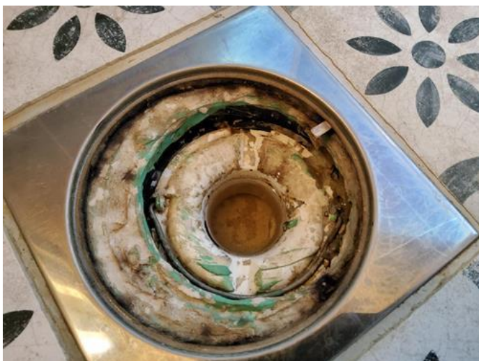
Membran, tettesjikt og overgang til sluk. - [Sluk i bad 2. etg. 4B ]
