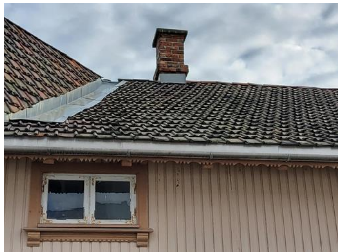
Yttertak - [Taktekking enebolig.]
