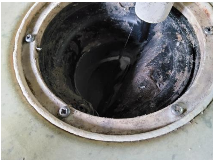
Membran, tettesjikt og overgang til sluk. - [Sluk i bad 2. etg. enebolig.]
