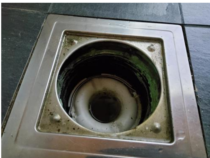
Membran, tettesjikt og overgang til sluk. - [Sluk i bad 1. etg. annek.]
