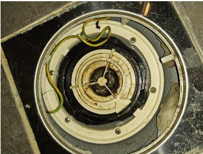
Våtrom - [Sluk, bad 5.etasje.]
