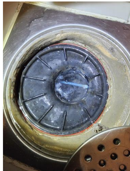
Våtrom - [Sluk på bad, 4.etasje ]
