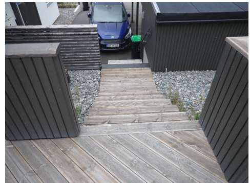
Mangler rekkverk
