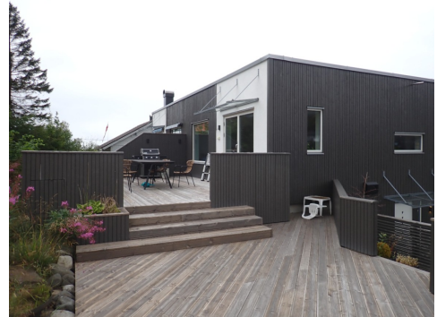
Mangler rekkverk
