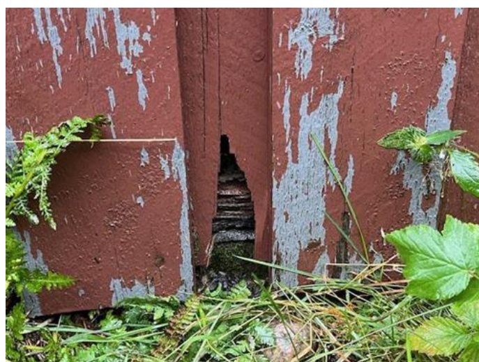
Yttervegger inkl. fasader og konstruksjon - [Råte på kledning og bunnsvill]
