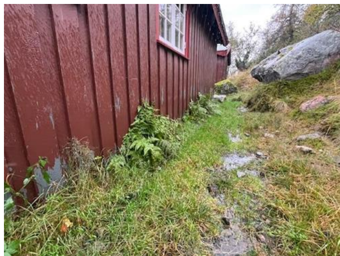
Beskrivelse - [Fall mot grunnmur og vegg avsluttet nær bakke]
