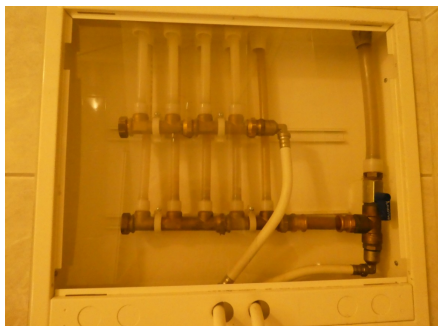
Fordelingsskap - rør-i-rør
