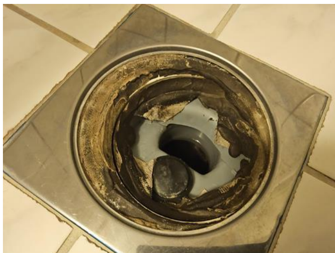
Våtrom - [Sluk bad nr 2.]
