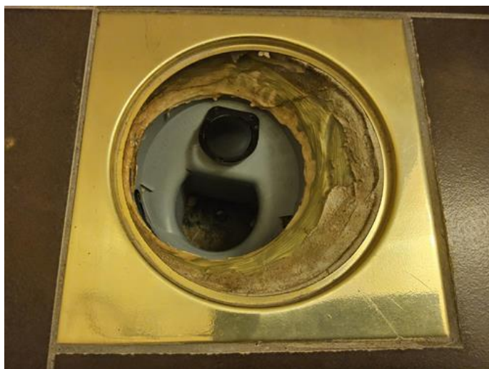
Våtrom - [Sluk bad nr 1.]
