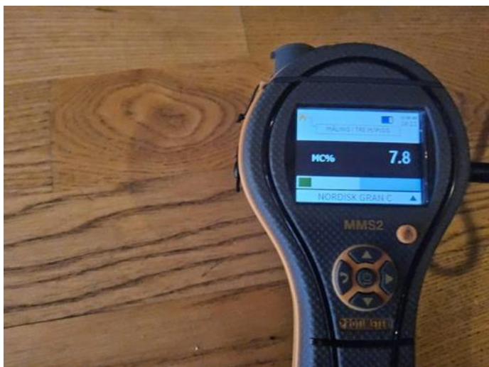
Våtrom - [Fuktmåling bad nr 1.]
