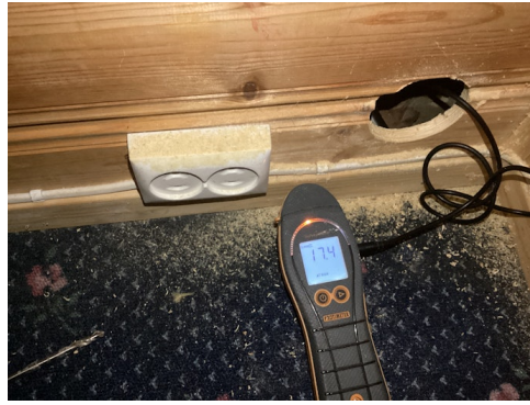
Bilde av fuktsøk
