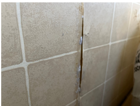
Utett tapetskjøt i våtsone.
