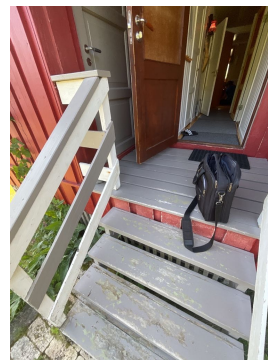
Rekkverks åpning på cirka 14cm.
