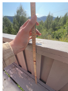
Rekkverks høyden er ca. 53cm.
