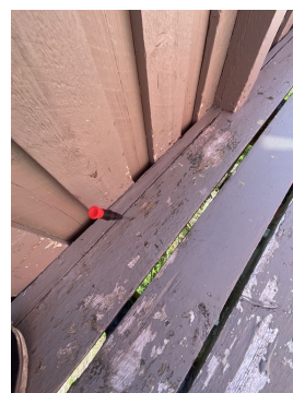
Håndlist bordet er delvis råttten på rekkverk.
