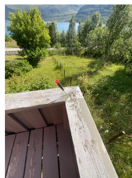
Håndlist bordet er delvis råttten på rekkverk.
