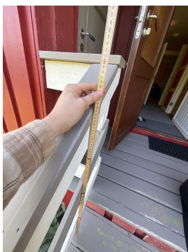
Rekkverks høyde på cirka 80cm.
