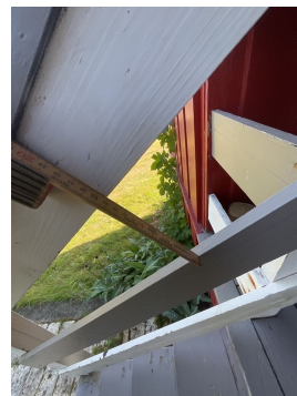
Rekkverks åpning på cirka 14cm.
