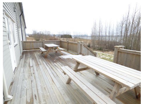
Veranda mot sør
