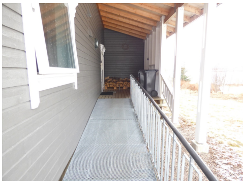
Trapp i tre samt rullestolrampe til inngangsparti
