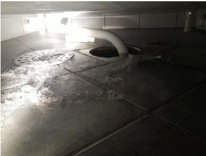
Avløpsrør (ink. sluk) - [Sluk bad-vask]
