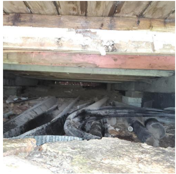
Utvendig - [Krypekjeller mot nord]
