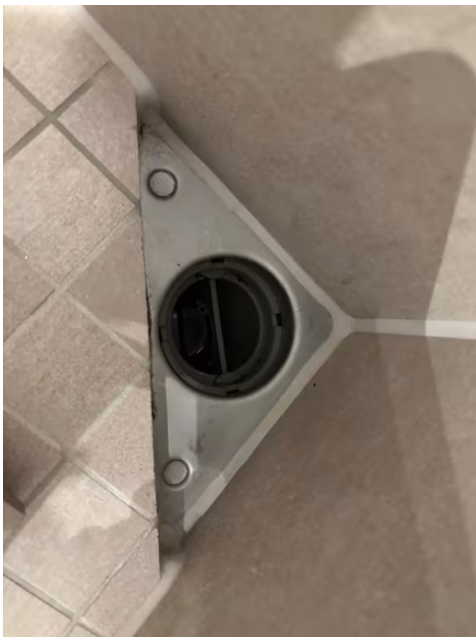
Baderomssluk plassert i dusjsonen.
