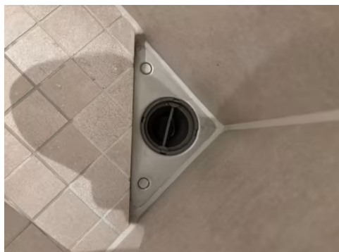
Baderomssluk plassert i dusjsonen.
