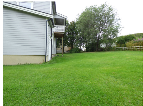
Terrenget heller inn mot boligen
