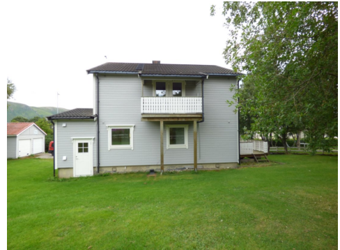
Overbygd luftebalkong mot nord
