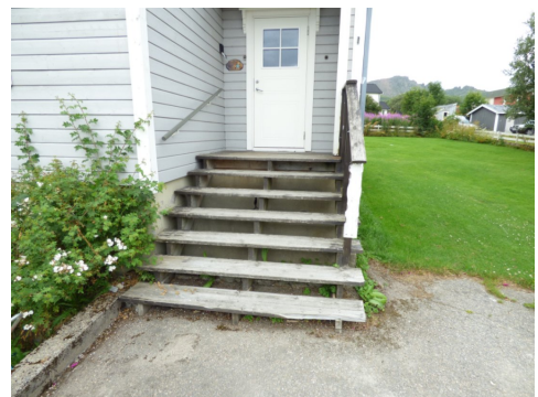
Trapp ved inngang
