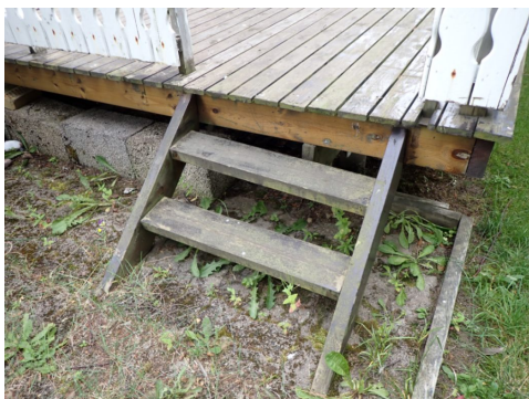
Trapp til veranda
