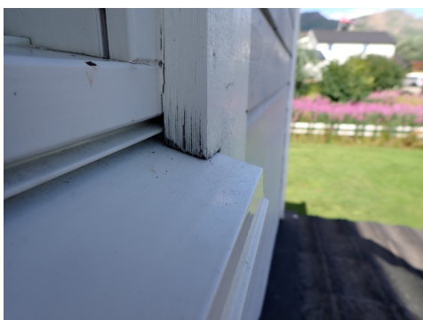
Utvendig omramming går helt ned til underbeslag
