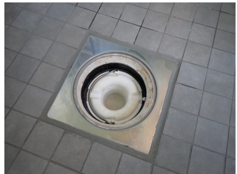
Sluk bad/vaskerom 1.etg
