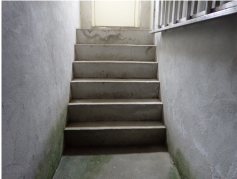
Trapp fra kjellerinngang til kjeller
