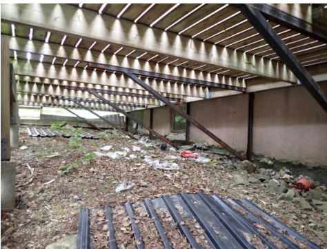
Understøttelse med vinkler i metall
