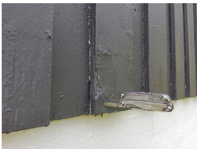
Yttervegger inkl. fasader og konstruksjon - [Eksempel på råteskader kledningsbord]
