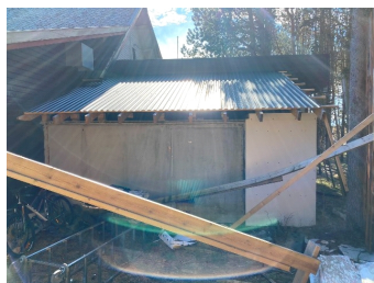
Noe gjenstående arbeider
