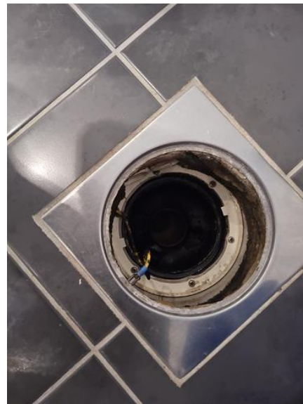
Membran, tettesjikt og overgang til sluk. - [Sluk]
