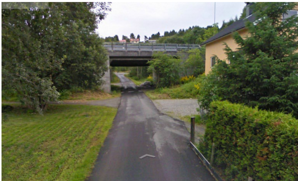
Figur 183 – Bilde av Nakkevikbrua, sett mot sør.
