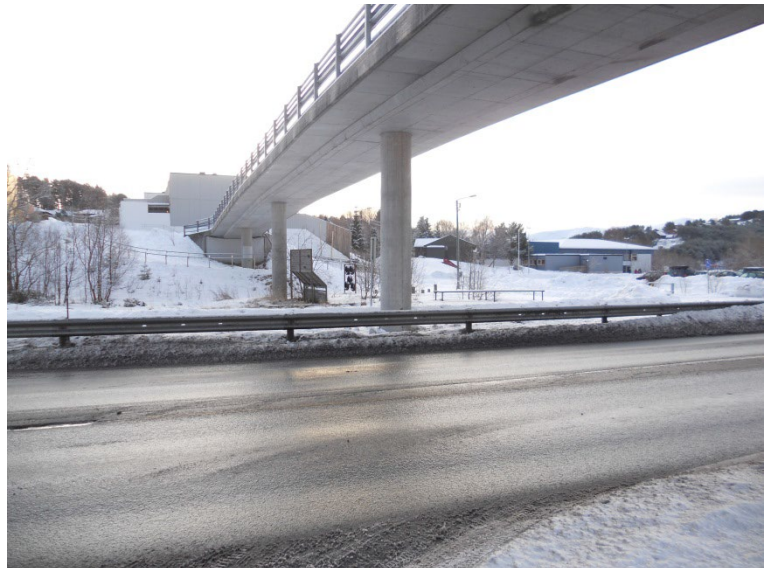
Figur 35 - Eksisterende gangbro ved Lerstad skole blir opprettholdt.
