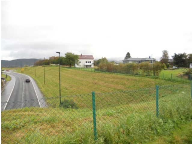
Figur 21 - Området ved Høgvoll sett fra toppen av Moatunnelen. Det hvite huset forutsettes innløst for å føre fram gangvegforbindelsen, som nå kobles til Vestre Høgvollveg rett til høyre bak dette huset.
