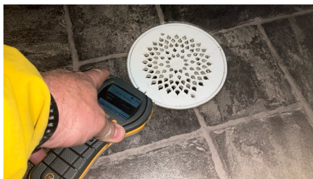
fuktsøk ingen utslag
