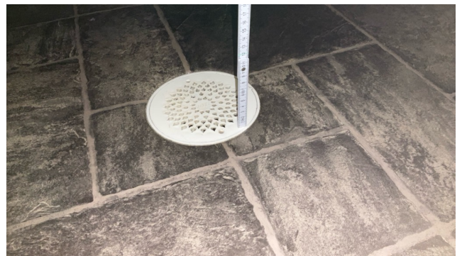
svakt fall til sluk (tilnærmet flatt)
