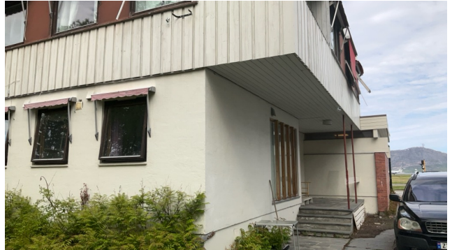
takoverbygd inngangsparti leilighet 2. etasje
