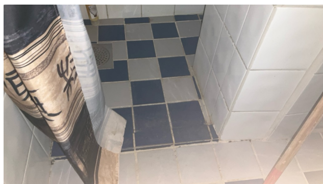
har dusjnische med oppbygget kant
