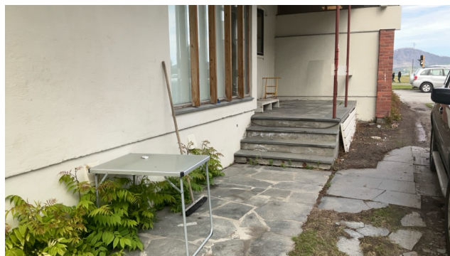
betongtrapp med skifertrinn
