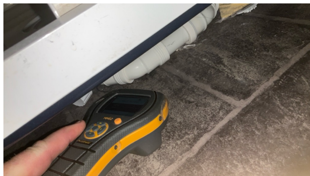
fuktsøk ingen utslag
