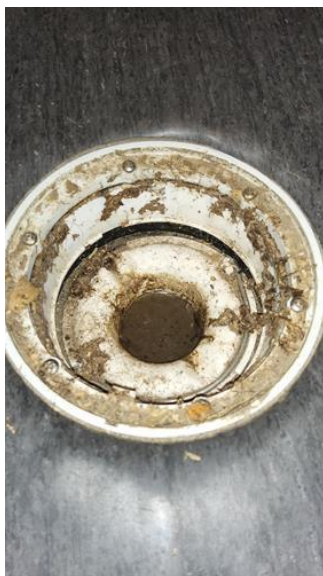
Avløpsrør (ink. sluk) - [Sluk bad i fjøs]
