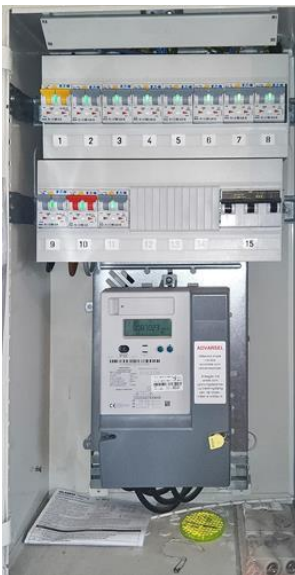
Forenklet vurdering av det elektriske anlegget - [Sikringsskap stue loftsetasje]
