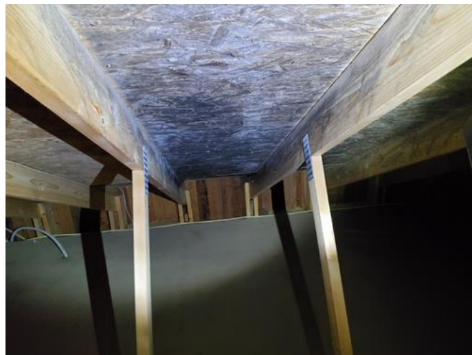
Loft - uinnredet / råloft - [Undertak kaldtloft.]
