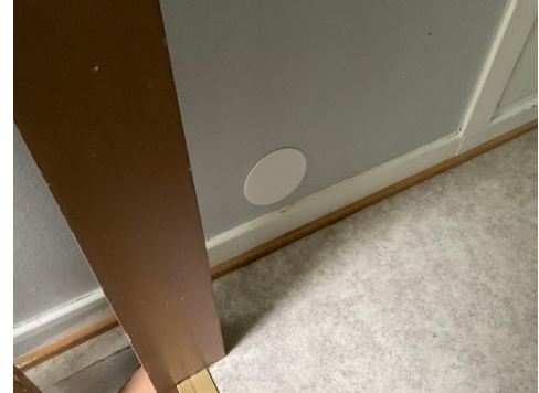
Borehull etter tetting
