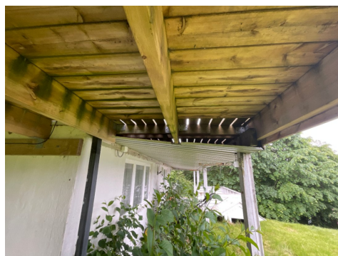
Underside balkong vest
