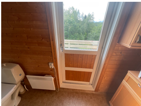
Dør til balkong fra bad.
