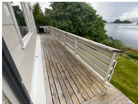
Del av rekkverket montert
