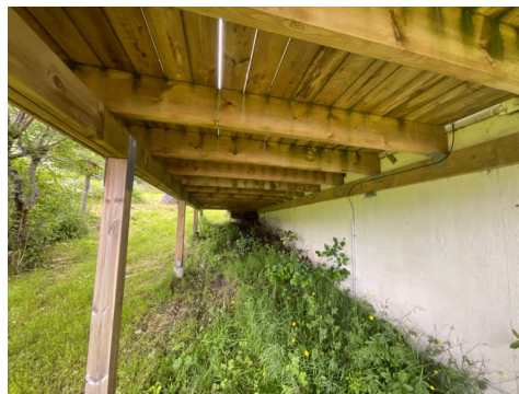
Underside balkong nord.
