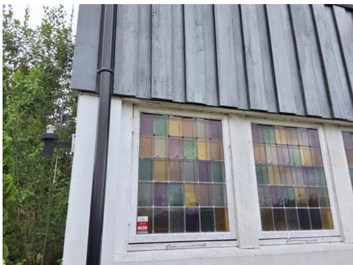
Yttervegger inkl. fasader og konstruksjon - [Yttervegger ]
