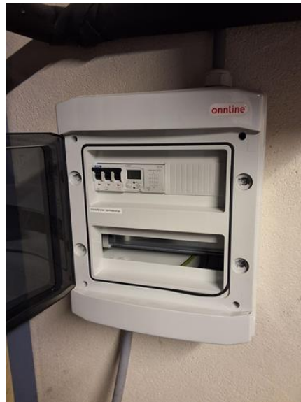
Tekniske anlegg, VVS anlegg (Sjekkpunkter utover det som er inkludert i andre rom) - [Sikringer varmepumpe]
