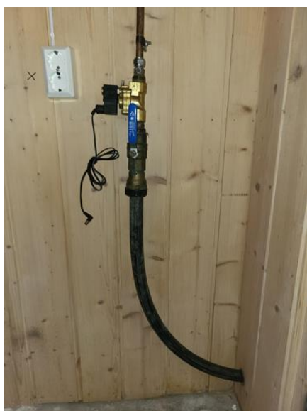
Tekniske anlegg, VVS anlegg (Sjekkpunkter utover det som er inkludert i andre rom) - [Hovedstoppekran]
