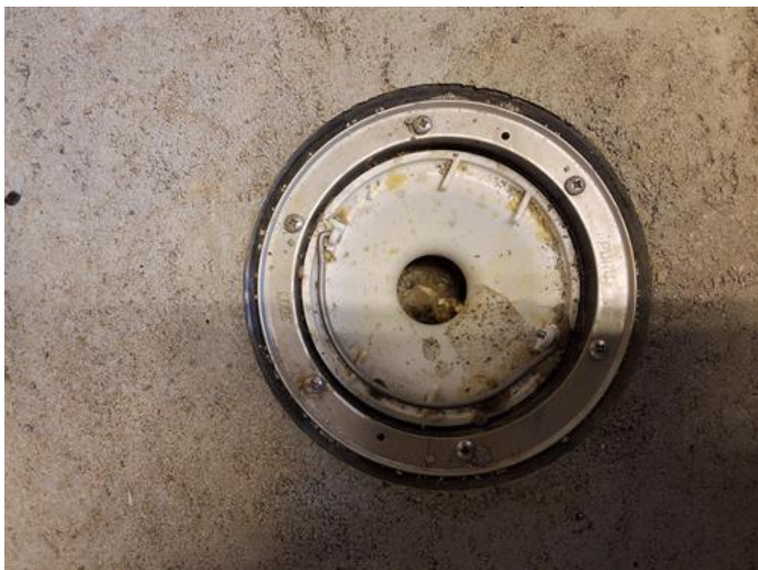
Tekniske anlegg, VVS anlegg (Sjekkpunkter utover det som er inkludert i andre rom) - [Nytt sluk i fyrrom]
