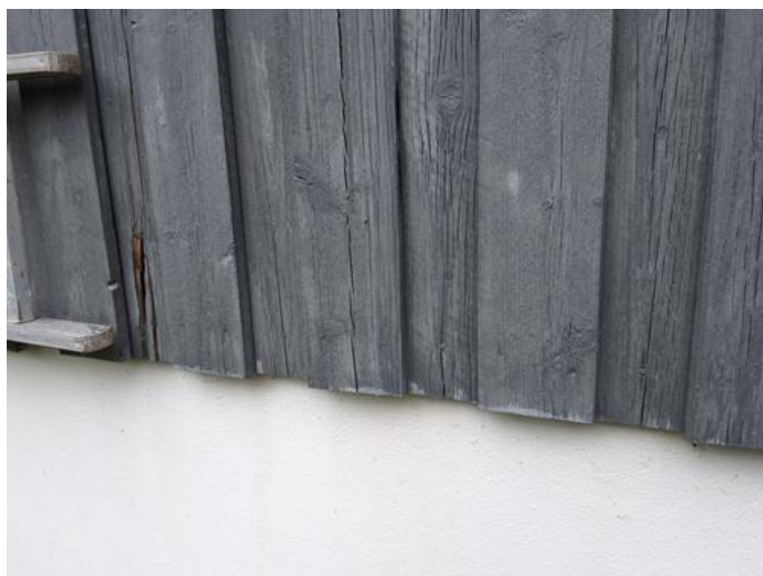
Yttervegger inkl. fasader og konstruksjon - [Yttervegger ]
