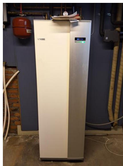
Tekniske anlegg, VVS anlegg (Sjekkpunkter utover det som er inkludert i andre rom) - [Varmepumpe i fyrrom]
