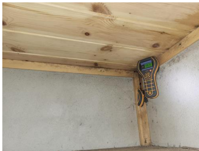
Rom under terreng (kjeller, underetasje, sokkeletasje) - [Tegn på fuktmerker i himling under bod, ikke forhøyd fuktmåling. ]
