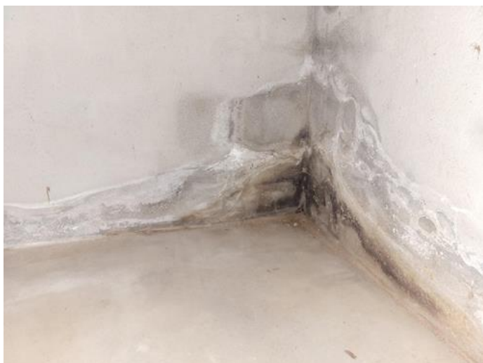
Rom under terreng (kjeller, underetasje, sokkeletasje) - [Fuktmerker i kjeller]
