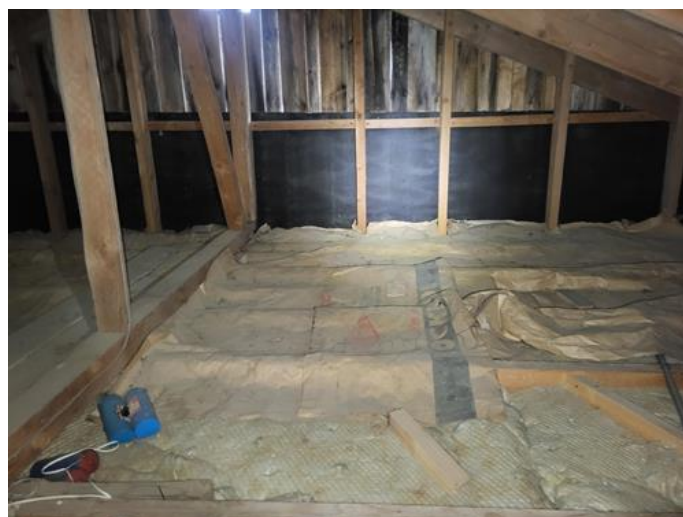
Loft - uinnredet / råloft - [Loft, gavl mot øst]
