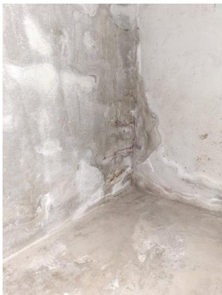
Rom under terreng (kjeller, underetasje, sokkeletasje) - [Fuktmerker i kjeller]
