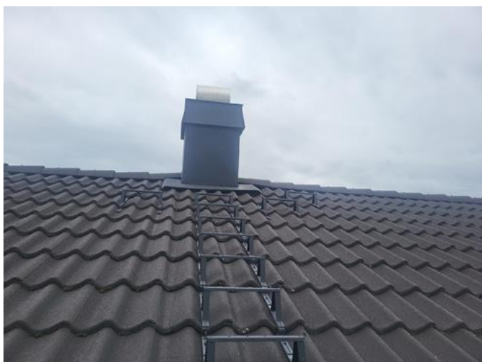
Yttertak - [Yttertak, stigeledd til pipe i møne]
