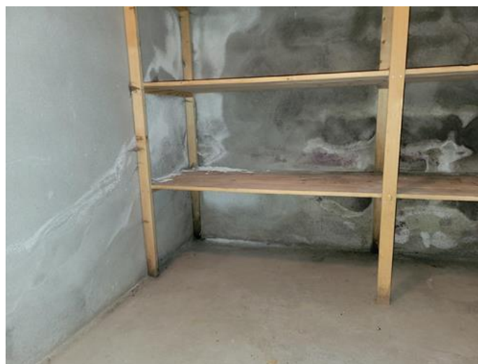
Rom under terreng (kjeller, underetasje, sokkeletasje) - [Fuktmerker i kjeller]
