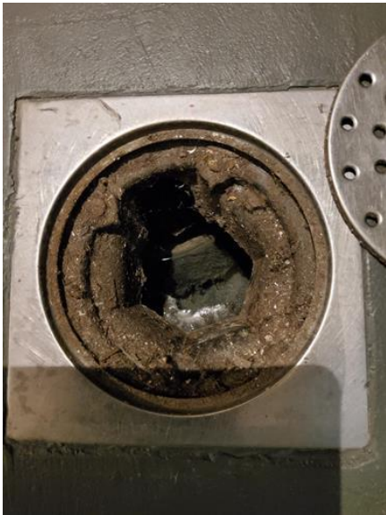
Membran, tettesjikt og overgang til sluk. - [Hovedsluk bad 1.]
