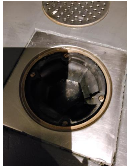
Membran, tettesjikt og overgang til sluk. - [Sluk i dusjsonen bad 1.]
