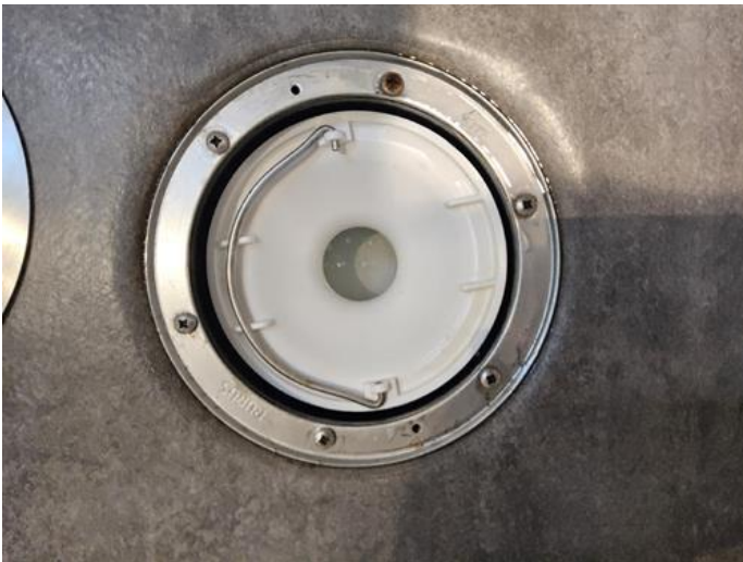
Våtrom - [Sluk bad.]
