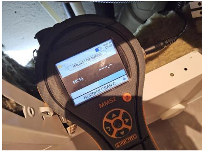
Våtrom - [Fuktmåling bad.]
