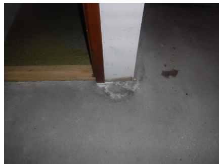
Det samme rundt pipa i vindfang
