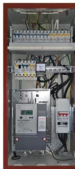
Forenklet vurdering av det elektriske anlegget - [Sikringsskap]
