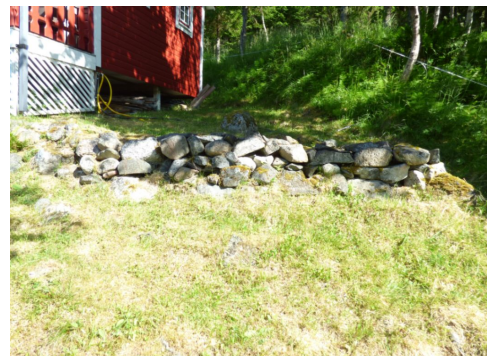
Eksempel på forstøtningsmur
