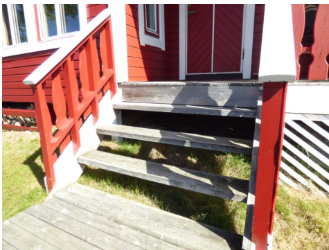
Trapp ved inngang, øvre del
