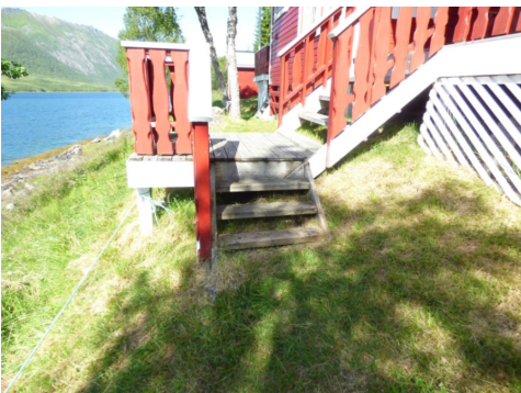
Trapp ved inngang, nedre del
