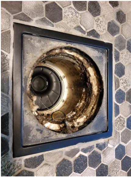
Membran, tettesjikt og overgang til sluk. - [Sluk i dusjsone. Bad/vaskerom. ]
