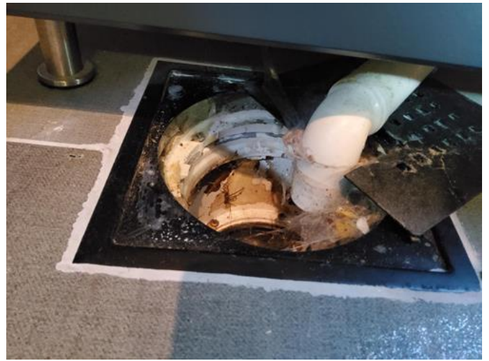
Membran, tettesjikt og overgang til sluk. - [Sluk utenfor dusjsonen. Bad/vaskerom. ]
