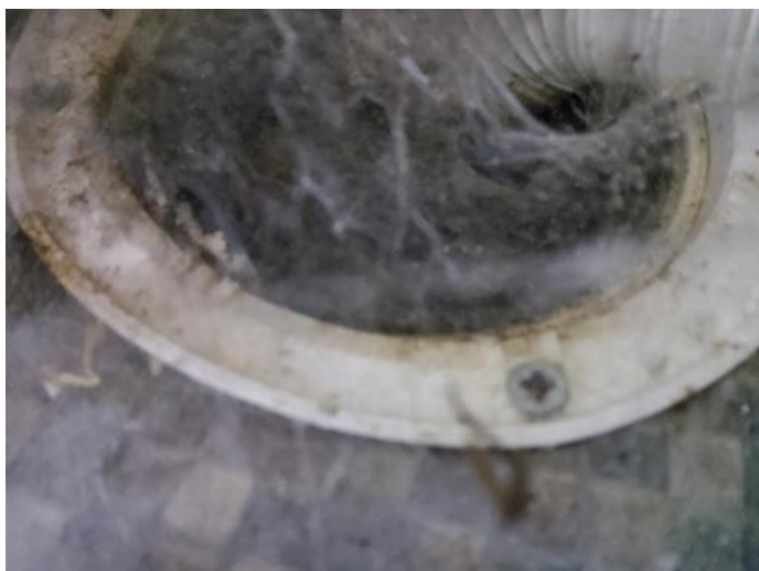
Membran, tettesjikt og overgang til sluk. - [Sluk i bad garasje.]
