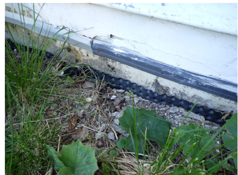
Glipper mellom innpussingslist og grunnmursplast
