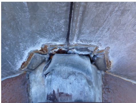
Hull/åpning i beslag ved pipa
