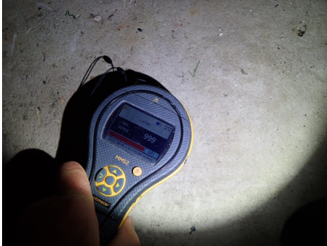
Fuktsøk, kott under trapp
