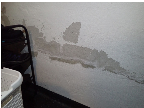
Flassing på yttervegg
