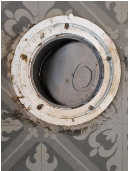
Slukets tilkomstmulighet for rengjøring - [Sluket under badekar. Bad 2 etg.]
