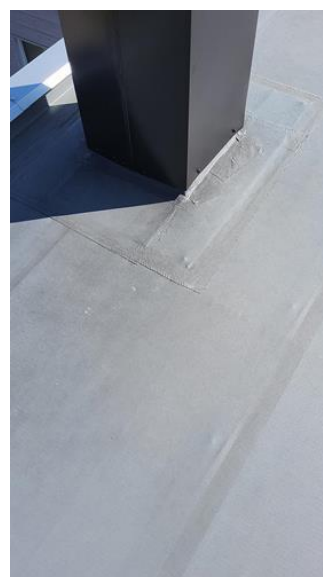
Konstruksjon - [Området uten tilstrekkelig underlag]
