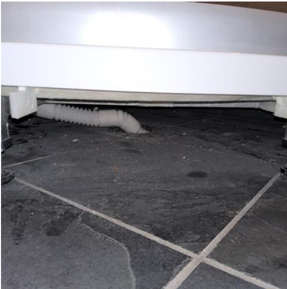
Innvendig - [Sluk under dusjkabinett bad 2.etasje ]
