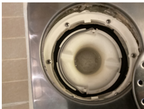
Bilde av sluk i dusjsone.
