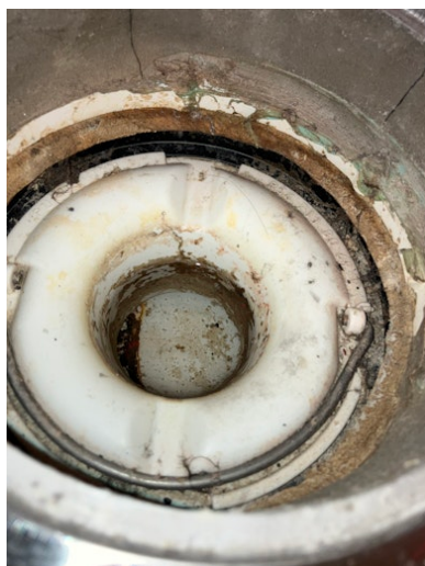
Bilde av sluk.
