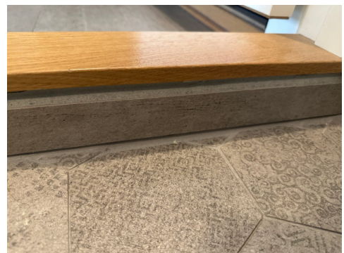
Overgang mot dørterskel.
