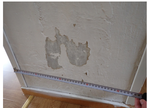
Eksempel på flassing, pipe
