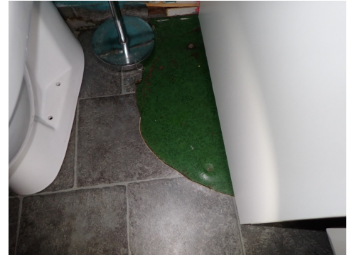
Deler av det øverste belegget mangler
