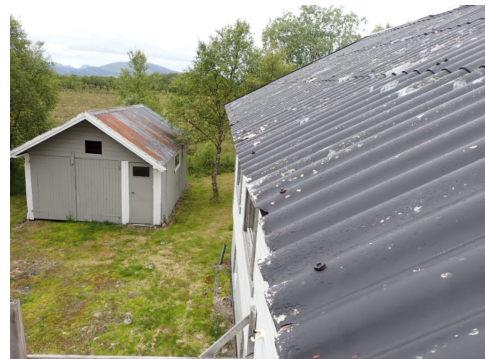
Skader i plater, hovedsakelig ved takfot mot sør
