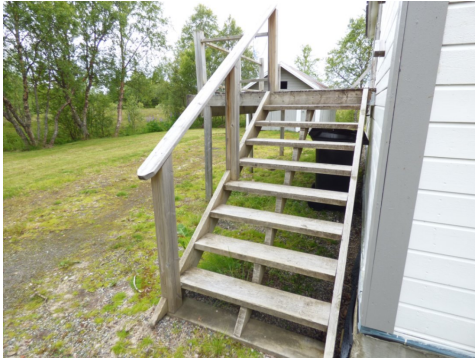
Trapp ved inngang
