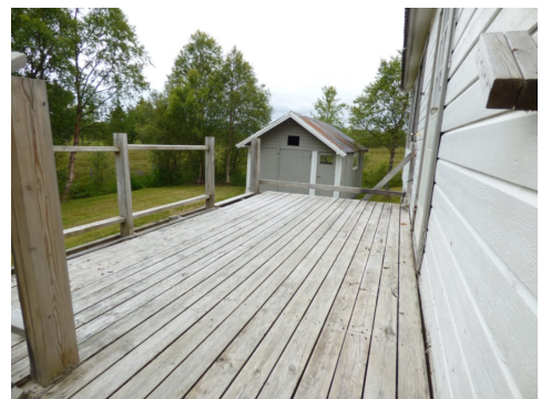
Veranda ved inngang
