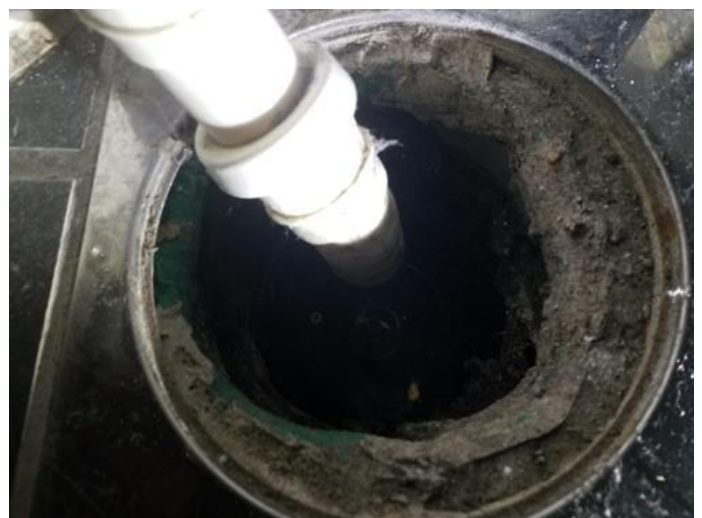
Membran, tettesjikt og overgang til sluk. - [Sluk i badetrom 1 etasje. Under utslagsvask.]
