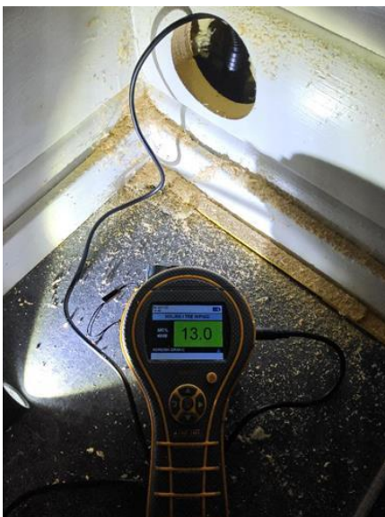
Våtrom - [Fuktmåling hytte nr. 76]
