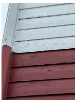
Råteskader i bordkledning ved bakkeniv
