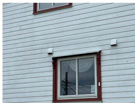
Dårlig lufting av bordkledning
