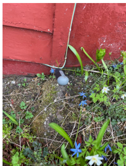
Råteskader i bordkledning ved bakkeniv
