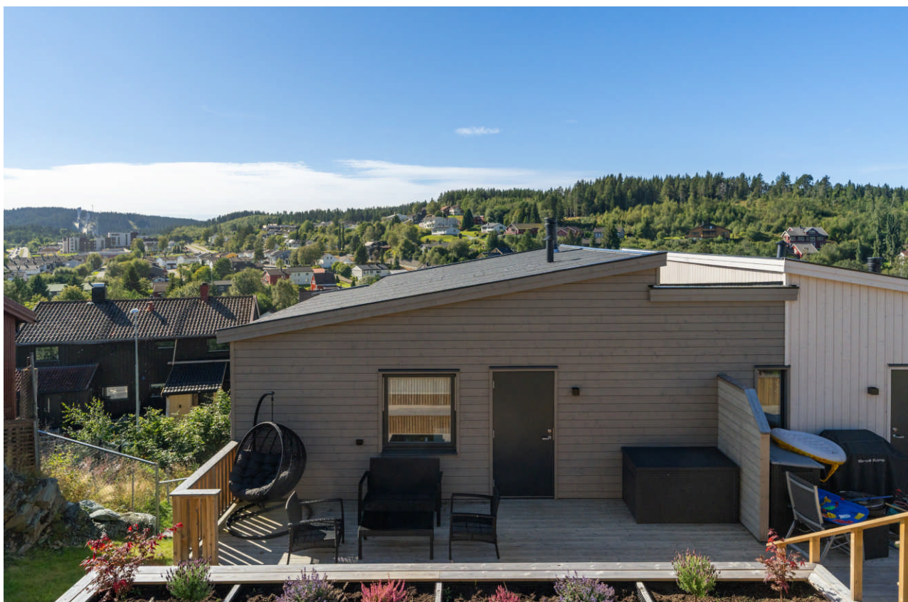
Skjermet og solrik uteplass på oversiden av huset.
