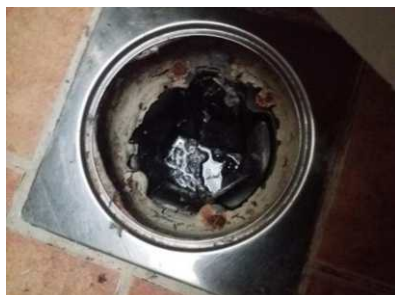
Membran, tettesjikt og overgang til sluk. - [Sluk i badrom i underetasje.]
