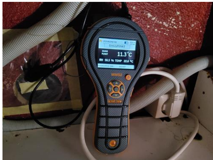
Kommentar - [Fuktmåling bad. ]
