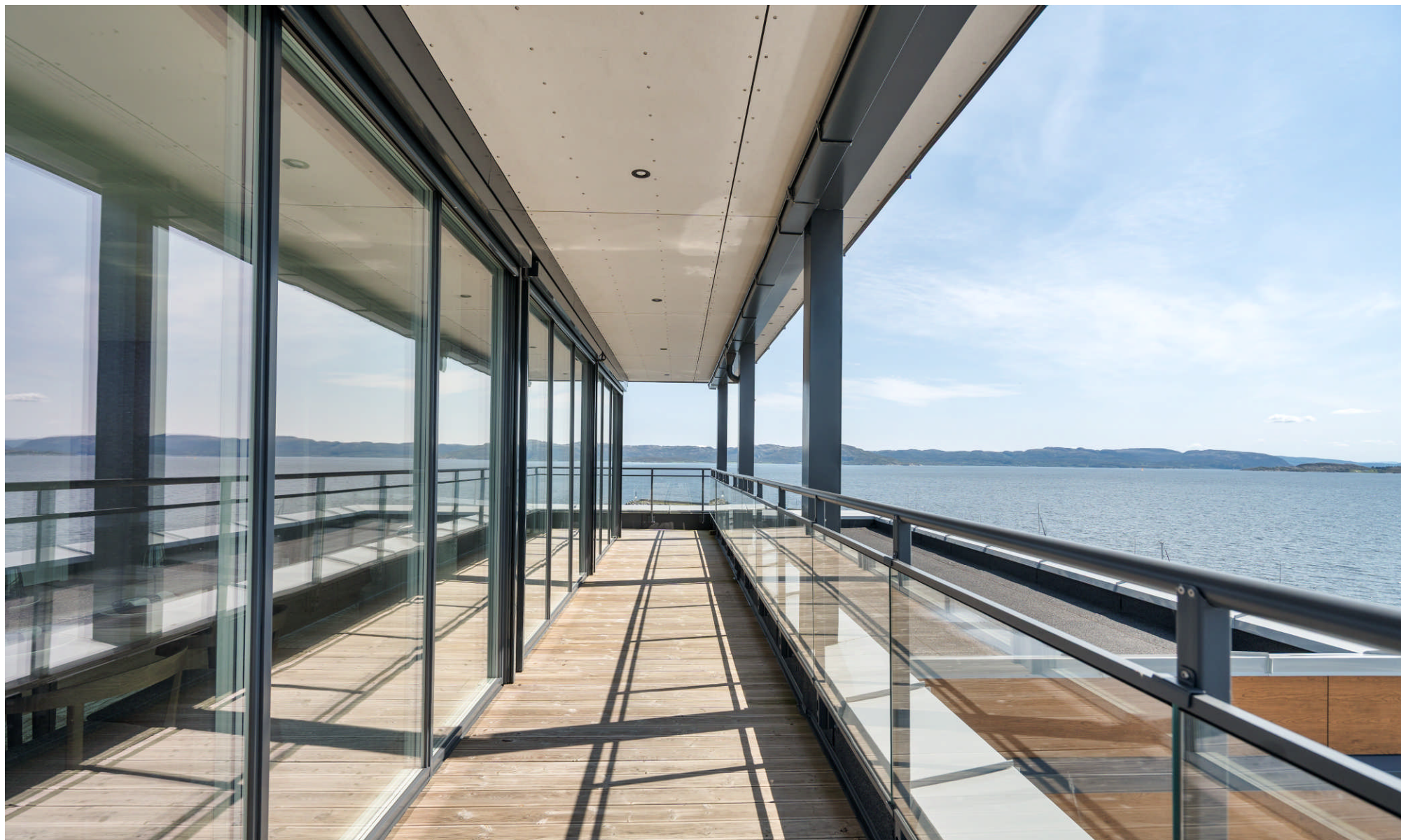
Svalgangen med downlights i tak, passer ypperlig med et koselig kaffebord.
