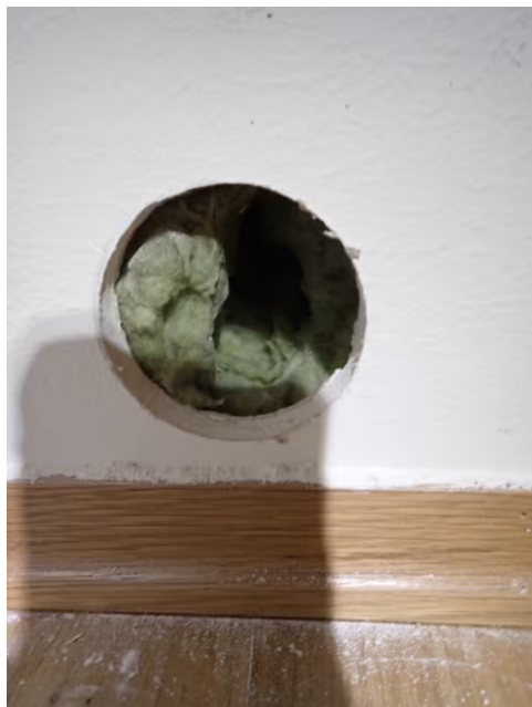
Hulltaking er utført fra tilliggende bod.
