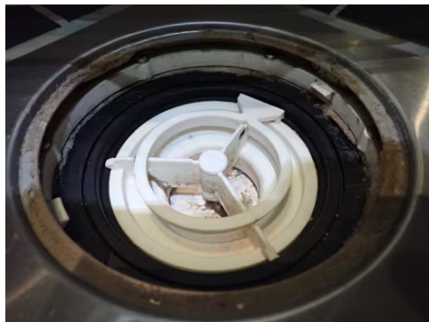
Synlig membran i sluk.
