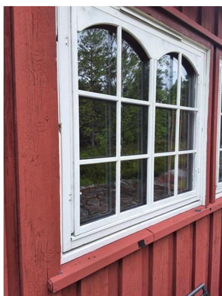
Yttervegger inkl. fasader og konstruksjon - [Vinduer]
