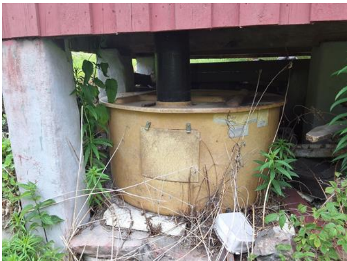
Utvendig - [Glassfobertank til snurredass]
