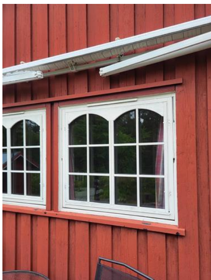
Yttervegger inkl. fasader og konstruksjon - [Vinduer]
