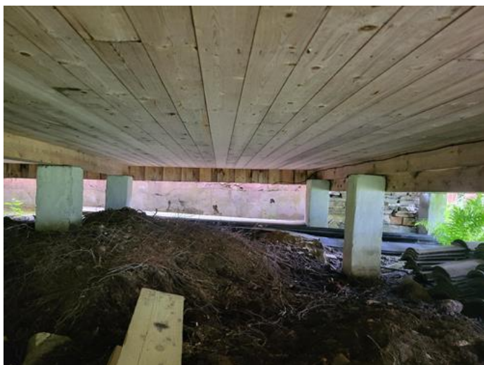
Utvendig - [Fundamenter under hytte ]
