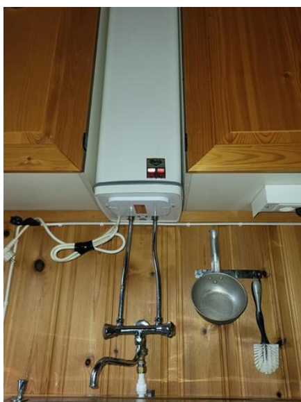
Tekniske anlegg, VVS anlegg (Sjekkpunkter utover det som er inkludert i andre rom) - [VVB på kjøkken]
