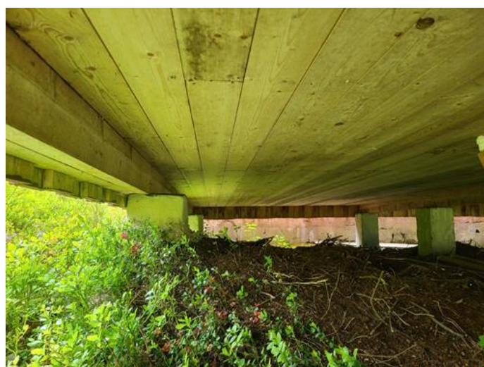
Utvendig - [Fundamnetter under hytte]
