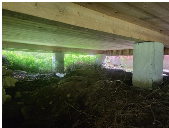
Utvendig - [Fundamenter under hytte ]
