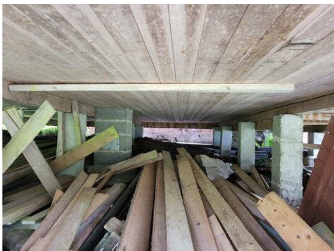
Utvendig - [Fundamenter under hytte]
