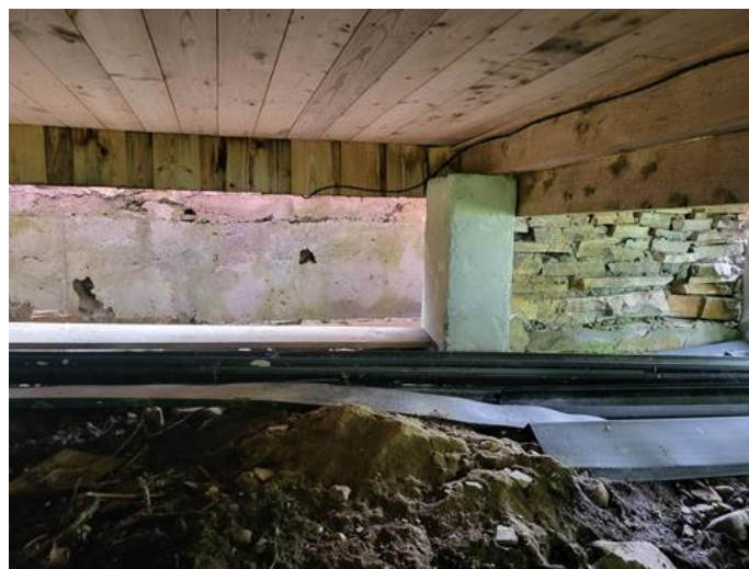
Utvendig - [Fundamenter under hytte ]
