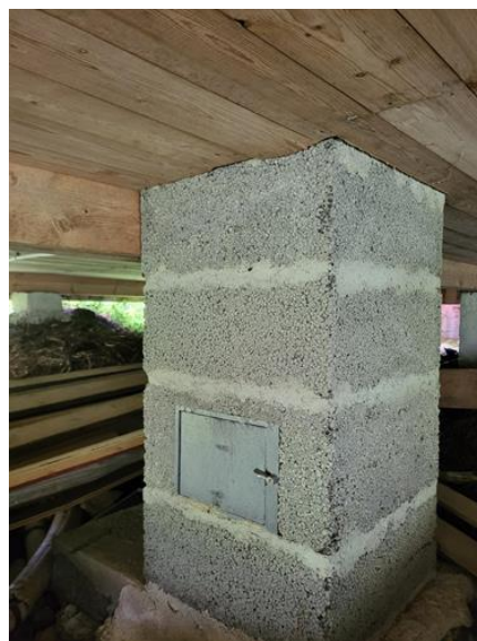
Utvendig - [Pipe og sotluke under hytte]
