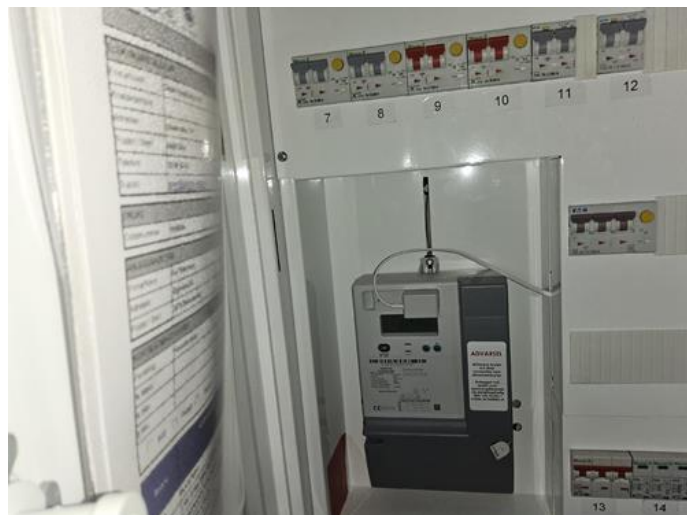
Elektrisk anlegg - [Sikringsskap med kursoversikt plassert i entre.]
