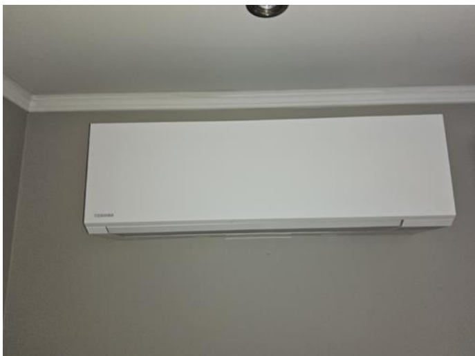
Tekniske anlegg, VVS anlegg (Sjekkpunkter utover det som er inkludert i andre rom) - [Varmepumpe stue.]
