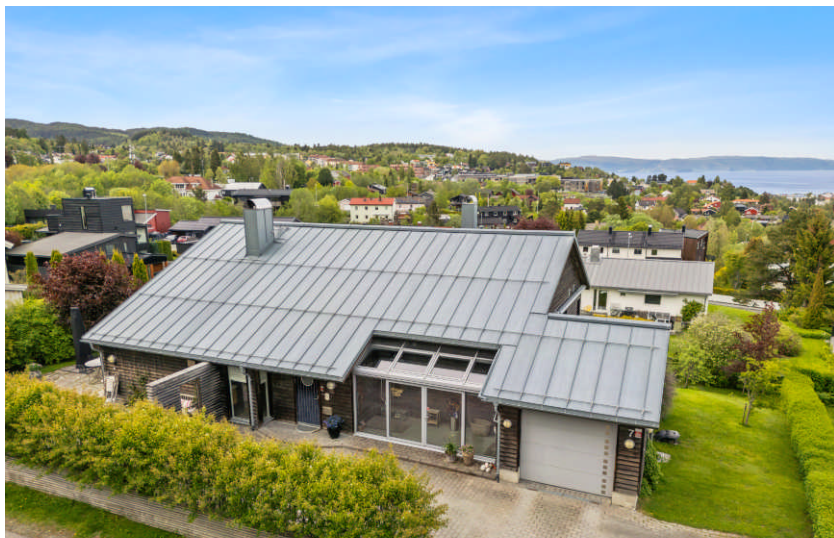
Gårdsplass med belegningsstein og varmekabler. Garasje med flislagt gulv, elektrisk port og uttak for lading av el-bil.
