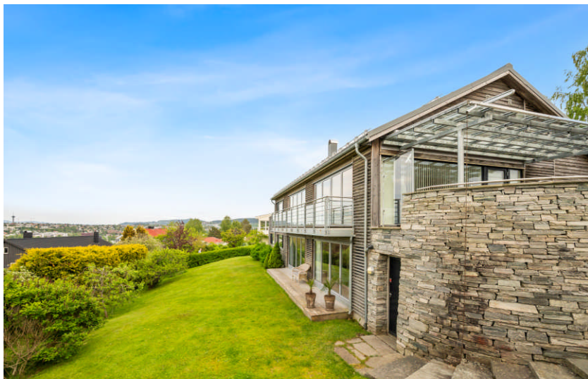
Boligen ble omtegnet av den anerkjente trondheimsarkitekten Per Knudsen i 2008 og gjenoppbygd med materialvalg av høy kvalitet.
