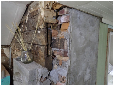
En side av pipa kledd inn (loft)
