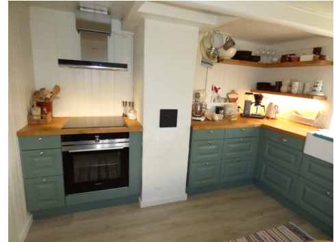
Sotluke på kjøkkenet
