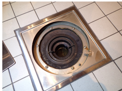
Sluk på bad/vaskerom
