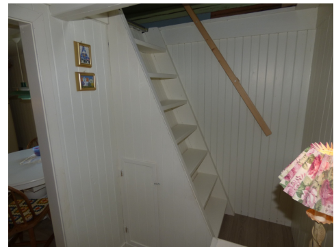
Relativt bratt trapp mellom etasjene
